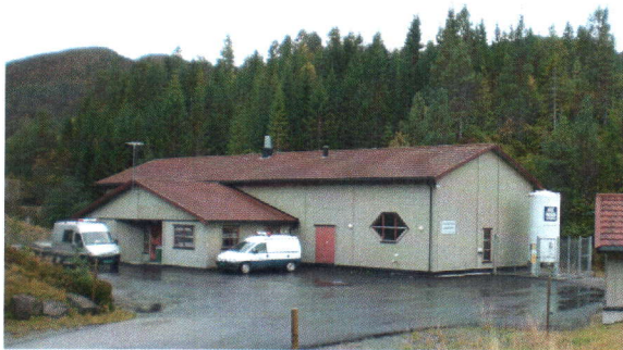
Tverrlia - behandlingsanlegg for vatn
