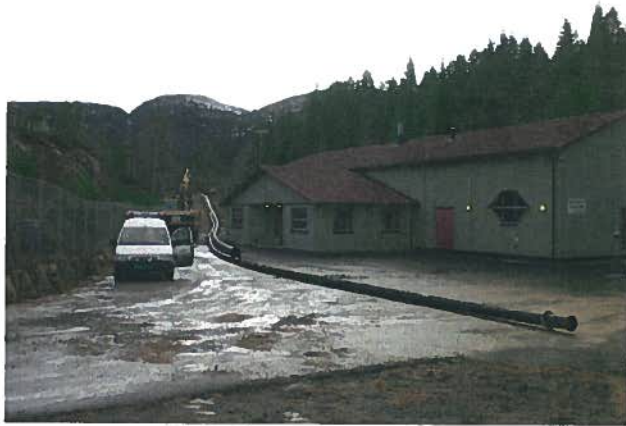
Bildet viser gamal inntaksleidning på veg ut av vatnet og ny leidning på vei ned og dimensjonane veks.
