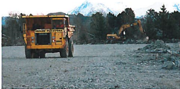
Grunnarbeid på skoletomta starta hausten 2010
