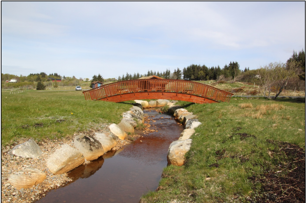
Figur 10 - Plastring av elvebreidd, start
