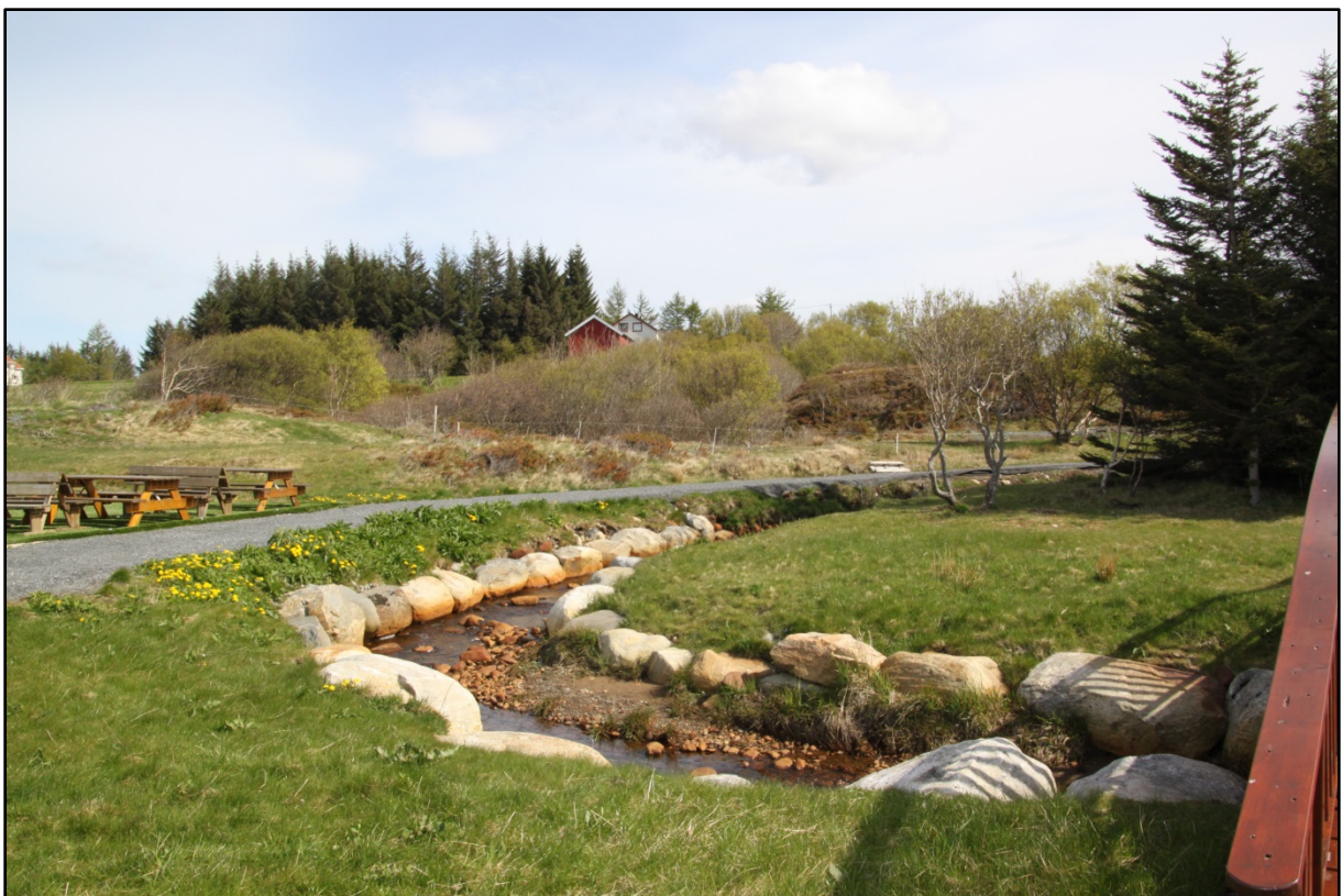
Figur 11- Plastring av elvebreidd, slutt
