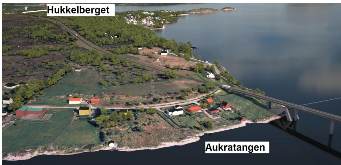
Figur 12 Vegtrase fra Aukratangen og nordover mot Hukkelberget
