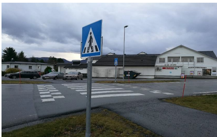
Eksempel på gjennomført tiltak i perioda 2013-2016. I samarbeid med Statens Vegvesen er det innført ny fartsgrense og tilrettelagt kryssing for mjuke trafikantar i sentrum (Falkhytten).
