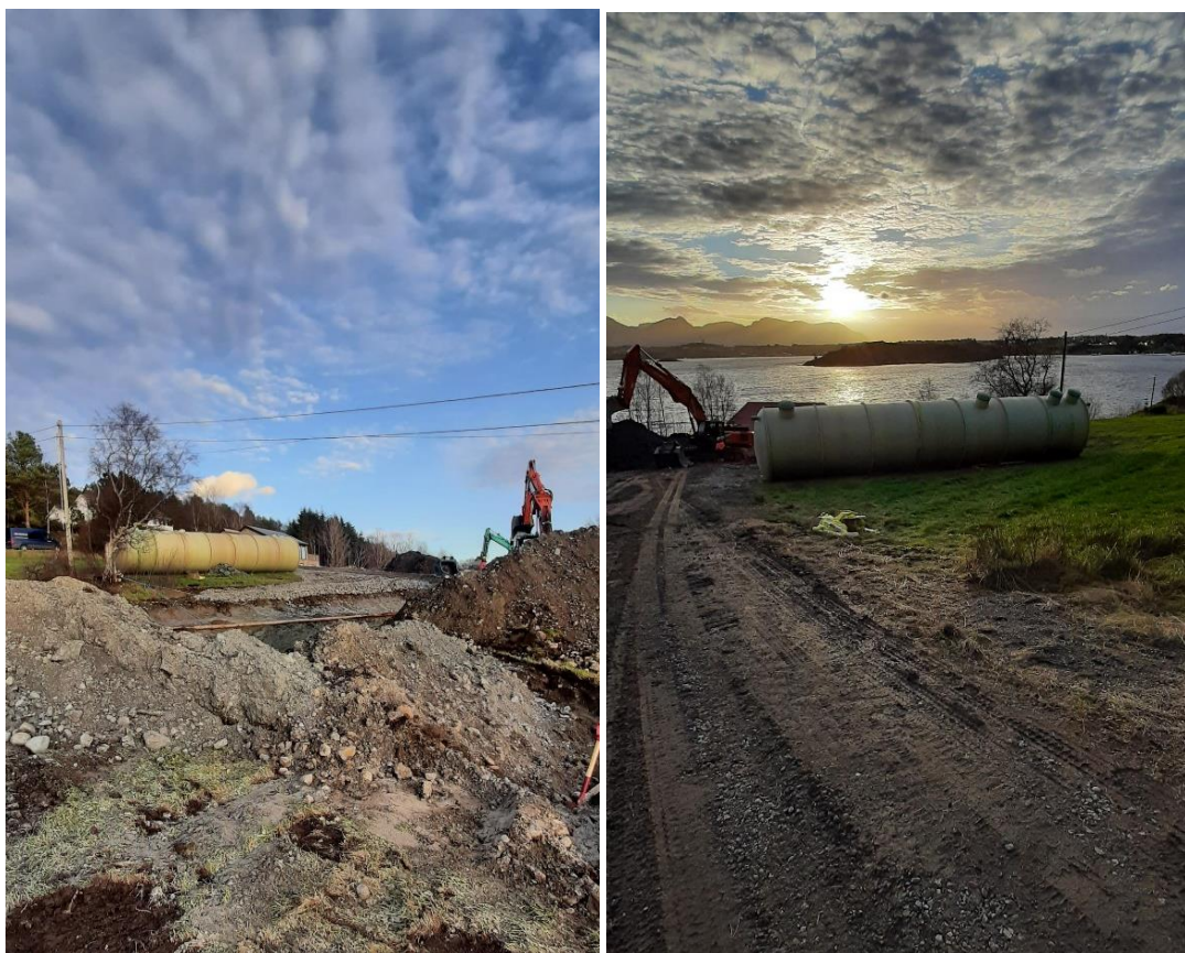
Figur 23: November 2021 var det lagt ned ein ny slamavskillar på Nerbøstranden.
