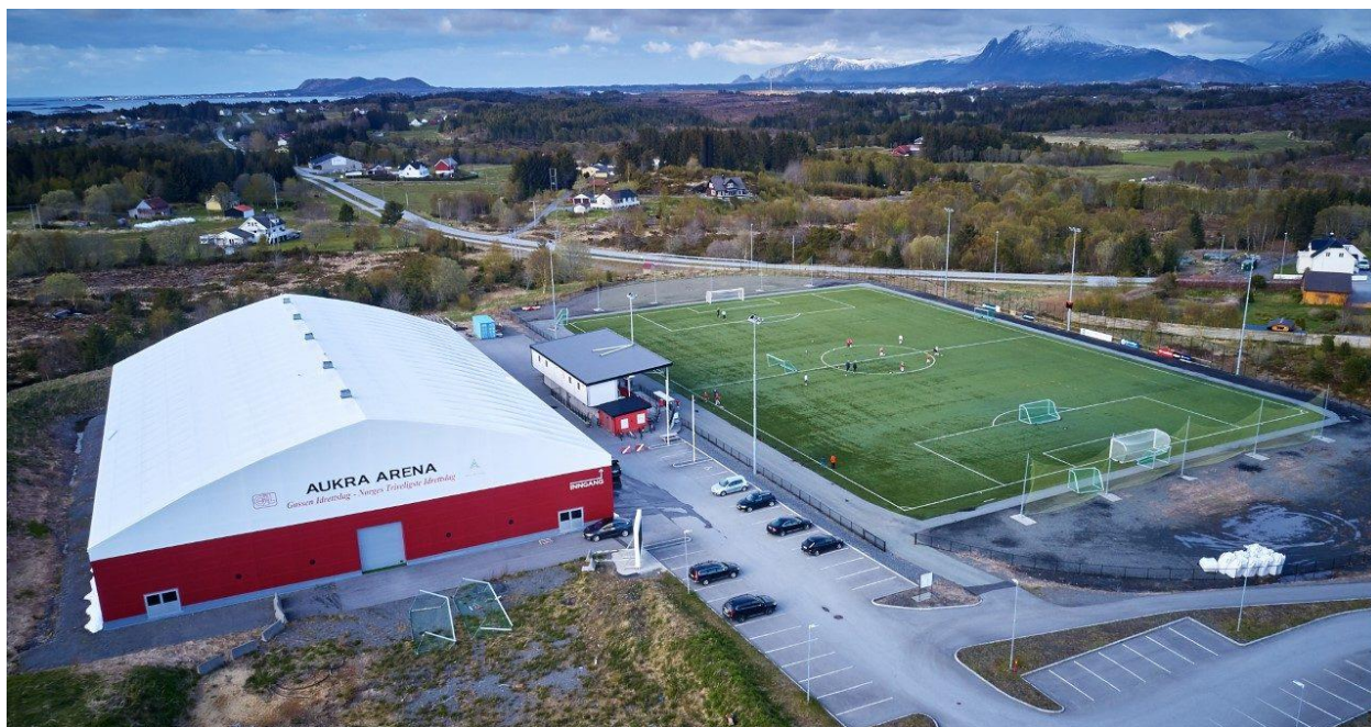
Figur 21: Aukra arena med Riksfjord Stadion
